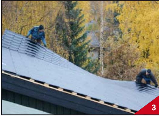
Pellit asetellaan paikalleen
