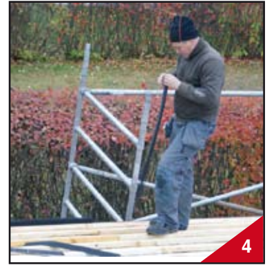
Tiivistenuhat paikalleen
