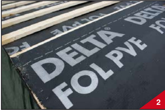
Aluskate ja ruodelaudoitus on asennettu
