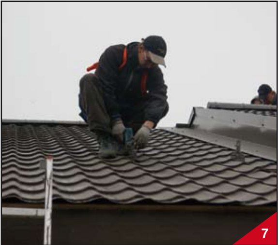
Peltikattoruuvit ovat kumitiivistettyjä
