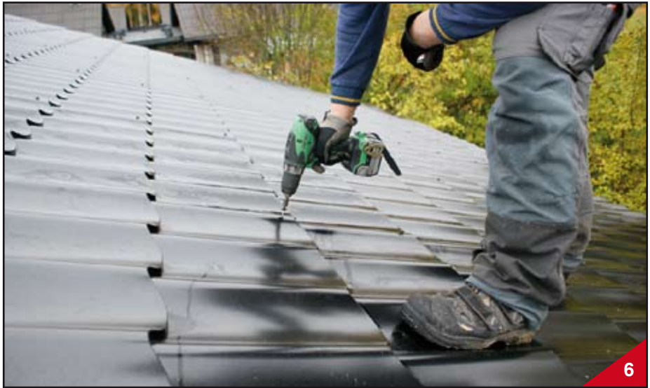
Kattolevyt ruuvataan akkukoneella kiinni
